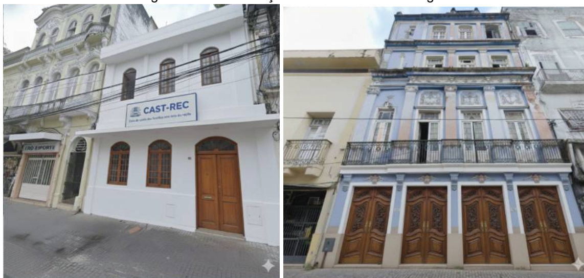
Figura 23 – Restauração das fachadas dos abrigos.
