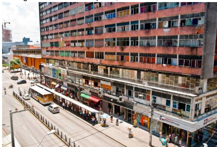
Figura 8 – Edifício Pirapama, AV. Conde da Boa Vista
