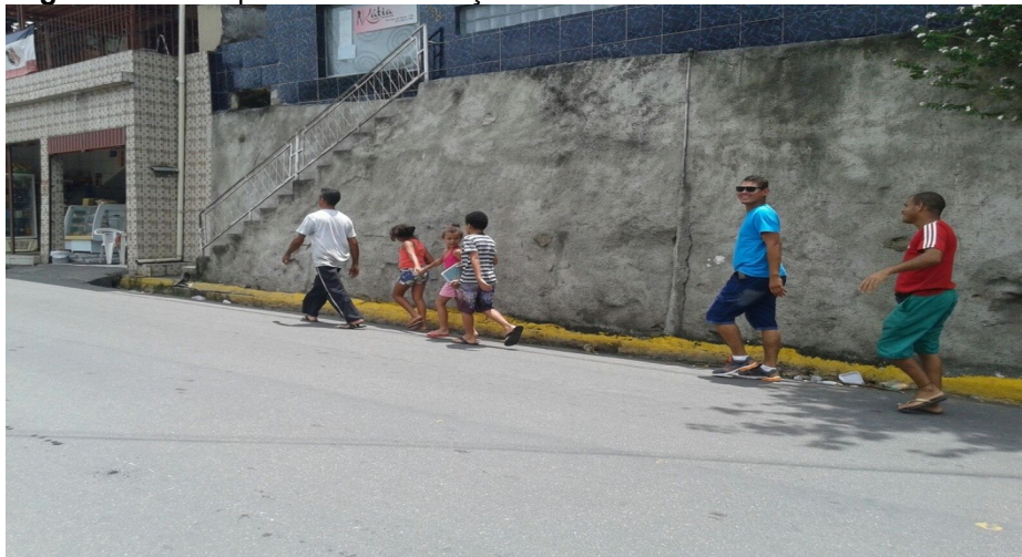
Figura 13: Exemplo de falta de calçada.
