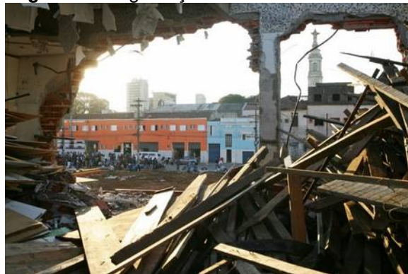
Figura 13: Degradação do bairro da luz
