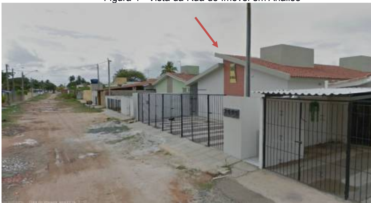
Figura 4 - Vista da Rua do Imóvel em Análise
