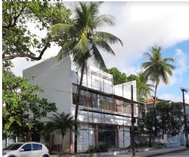
Figura 10 – Processo de restauro ocorrendo em outubro de 2019.
