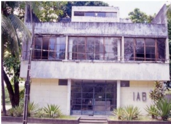
Figura 06- Fachada Oeste antes do restauro realizado em 2002.
