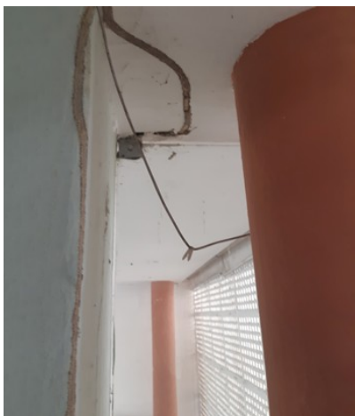
Figura 21- Ataque de térmitas no primeiro pavimento
