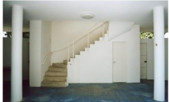
Figura 05- Entrada do edifício depois do restauro
