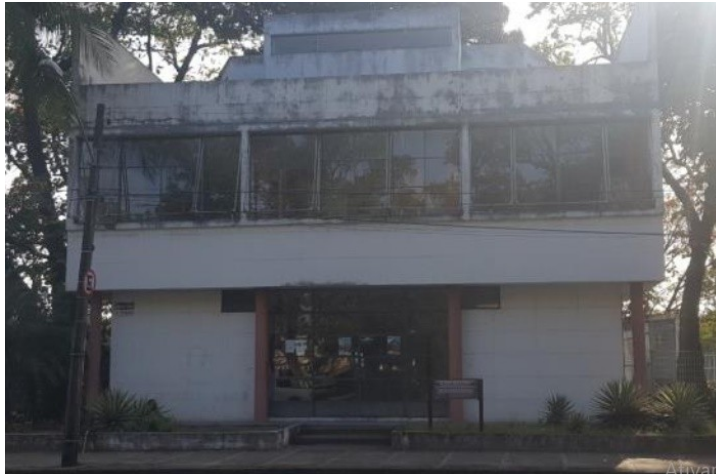
Figura 01 – Fachada Oeste do Pavilhão Luiz Nunes em julho de 2019.
