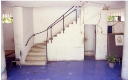
Figura 04- Entrada do edifício antes do restauro
