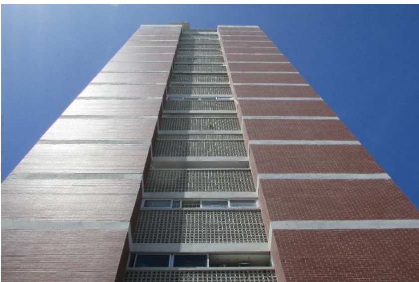
Foto 32: Três elementos e uma arquitetura – O outro lado do edifício Barão do Rio Branco
