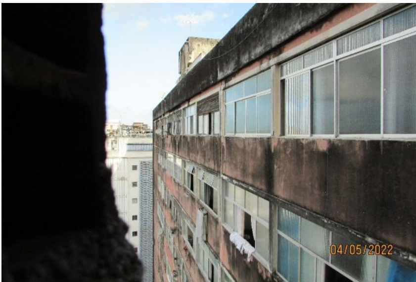
Foto 31: Pirapama – “Prédio Bravo”
