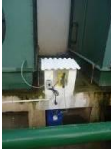
Figura 1: Sistema de climatização automatizado
